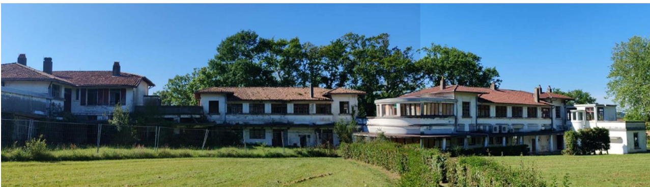
Les bâtiments à remplacer : vue extérieure (haut) et intérieure (bas) du domaine
